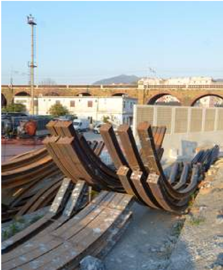
Un cantiere del nodo ferroviario genovese: altro stop ai lavori
